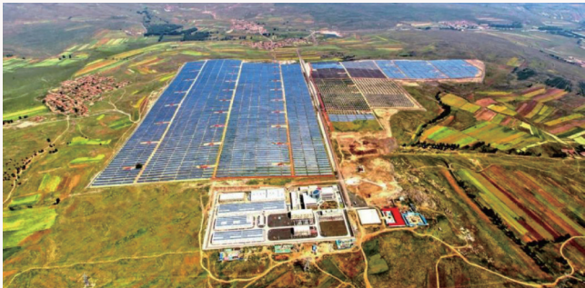
图 3.7 张北风光储输基地虚拟同步机技术示范工程
