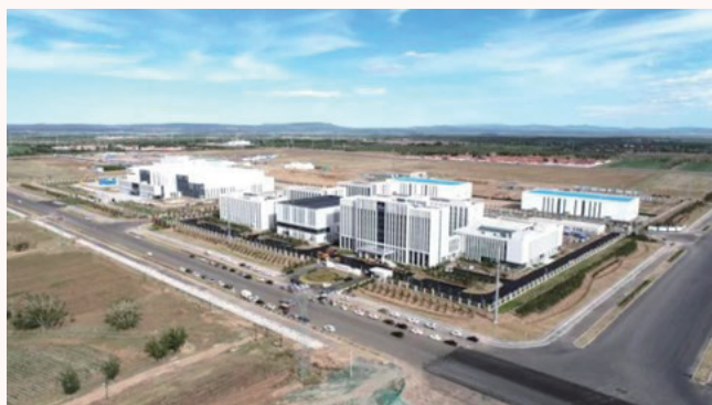
图 8.2 三峡现代能源创新示范园
