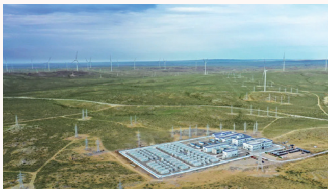
图 8.1 三峡乌兰察布新一代电网友好绿色电站示范项目
