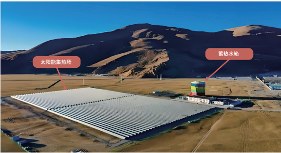
图 8.3 西藏仲巴县大规模跨季节储热示范项目
